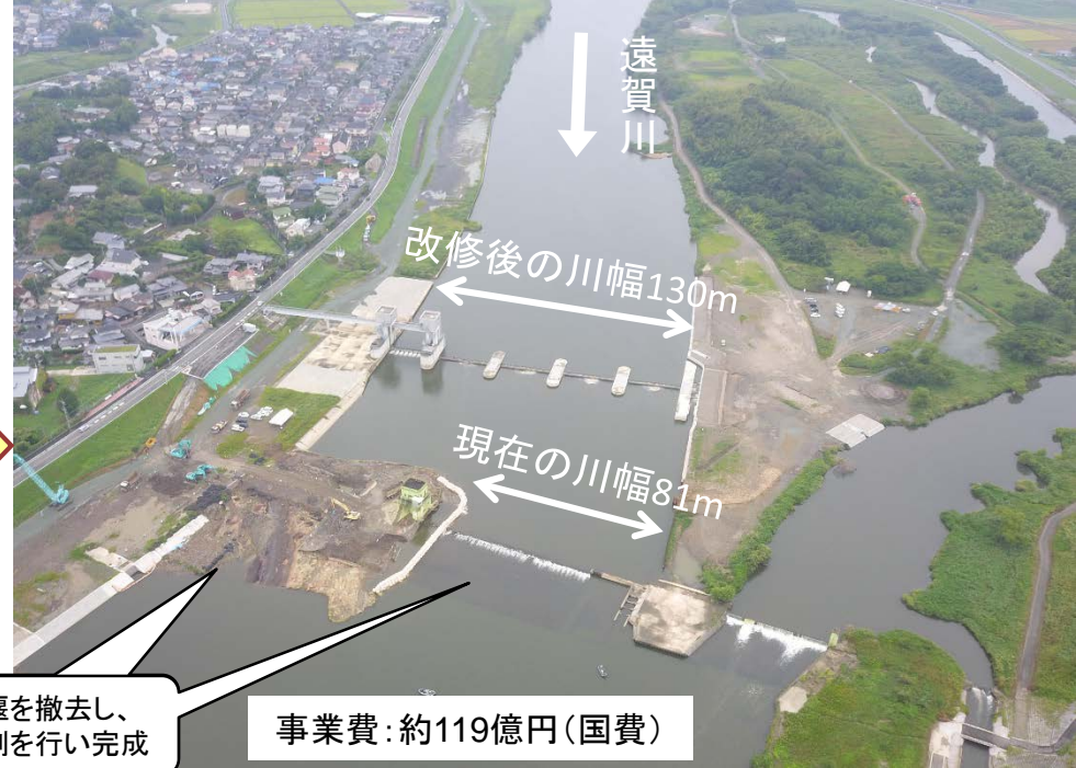
■ 中間堰の工事状況<特定構造物改築事業>(平成30年9月現在)
