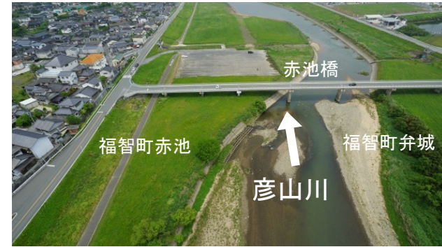
■赤池橋付近の掘削工事着手前
