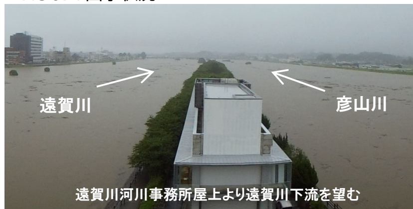
■H30. 7出水状況
