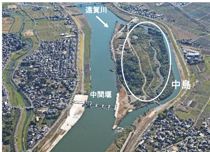
航空写真（中間堰及び中島）
