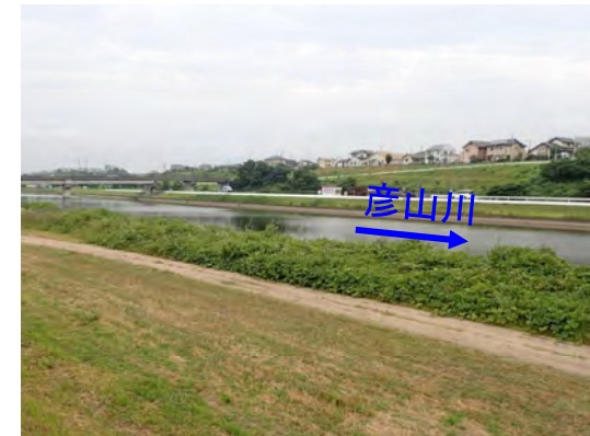
高水敷の不陸が大きいため安全に水辺を利用しにくい状況（下流域）
