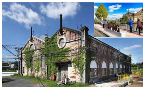
世界遺産「遠賀川水源地ポンプ室」
