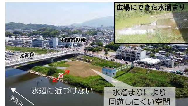
土砂堆積や草木の繁茂により水辺に近づくことができない。また、広場に雨水が溜まりやすい
