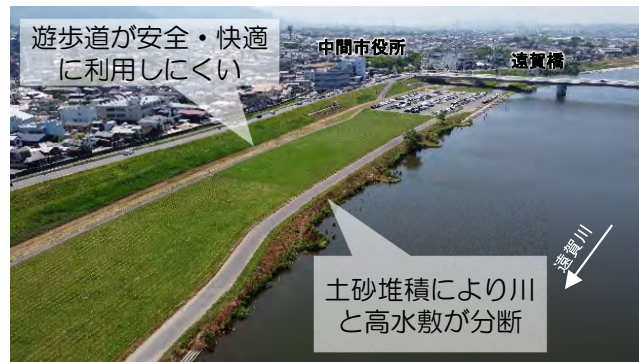
土砂堆積により川と高水敷が分断されている。遊歩道の利用安全性に課題。
