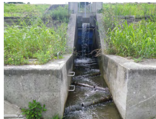
魚類等の移動経路確保のための丸太の設置
