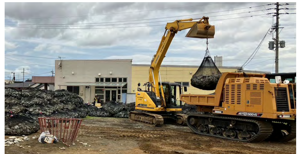
資材運搬状況(7月13日撮影)
