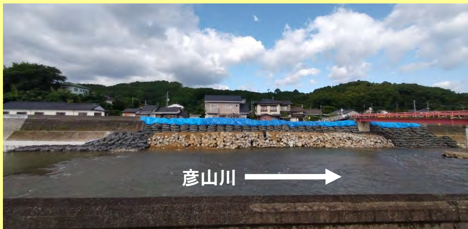
復旧完了(7月16日 9時00分撮影)
