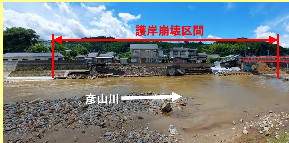
被災状況(7月11日撮影)
