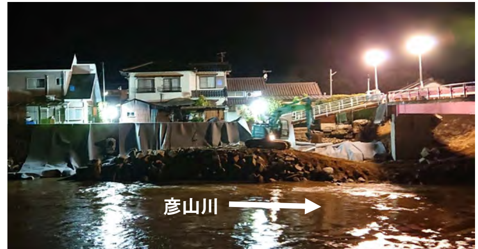
復旧状況(7月11日夜間撮影)
