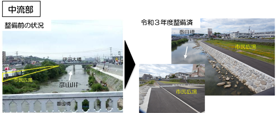
彦山川河川敷の水際に樹木が生い茂り、安全に水辺に近づきにくい状況。
