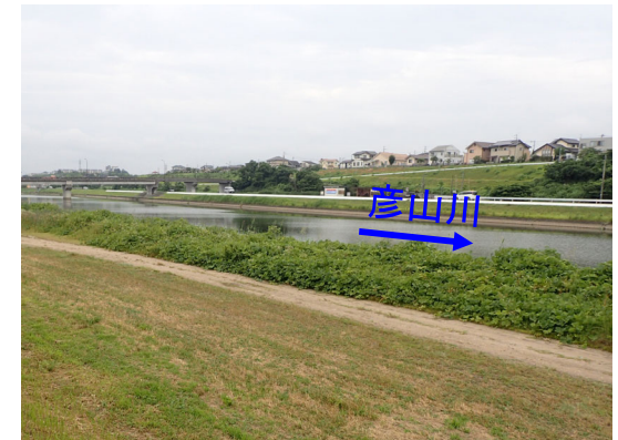
高水敷の不陸が大きいため安全に水辺を利用しにくい状況(下流域)
