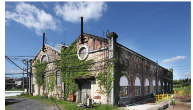
遠賀川水源地ポンプ室(中間市)
