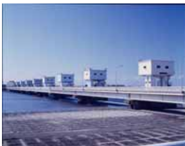
〔堰：遠賀川河口堰〕
