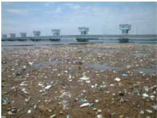
写真2.2.36 出水後の遠賀川河口堰貯水池の状況
