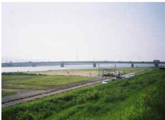
写真2.2.27 河川敷広場(中間市)
