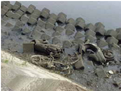
写真2.2.35 ゴミ投棄状況
