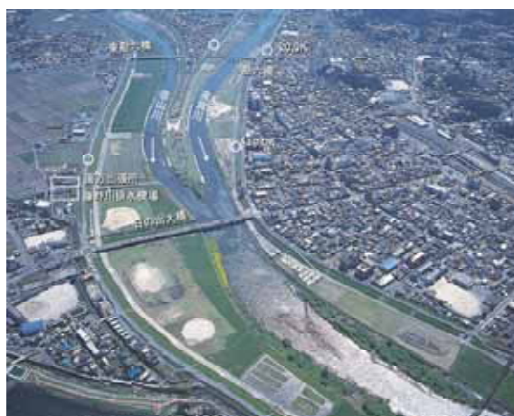
写真2.2.3 遠賀川中流部(直方市)
