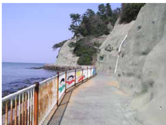
写真2.2.30 波懸け遊歩道(芦屋町)
