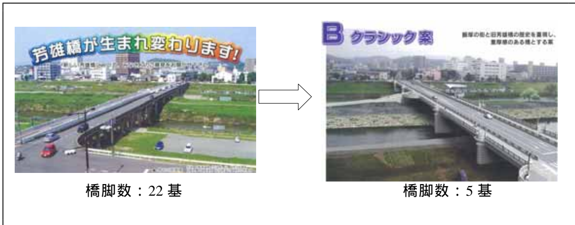
写真4.2.3 橋梁架替（遠賀川芳雄橋の架替プラン）
