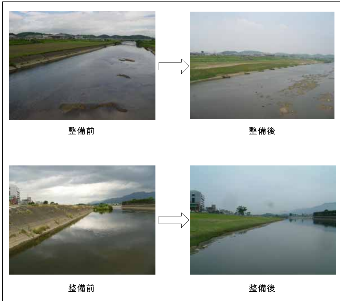
写真4.2.1 施工事例（直方市）
