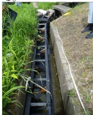
簡易魚道の設置(御徳地区)
