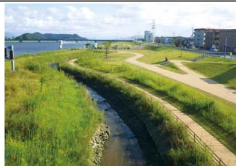
遠賀川河口堰の多自然魚道(整備後)
