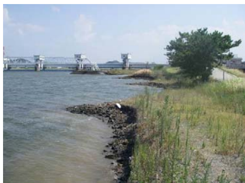
水制工の設置
