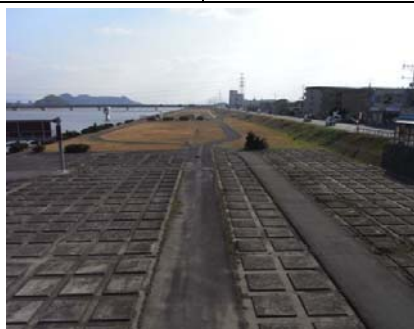
遠賀川河口堰の多自然魚道(整備前)
