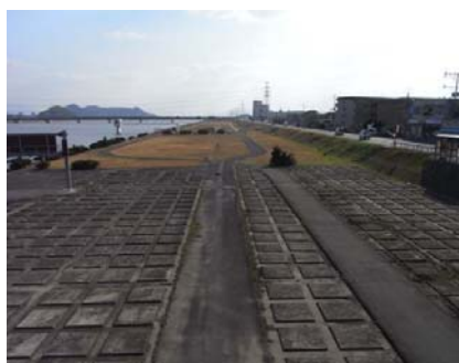
遠賀川河口堰の多自然魚道(整備前)
