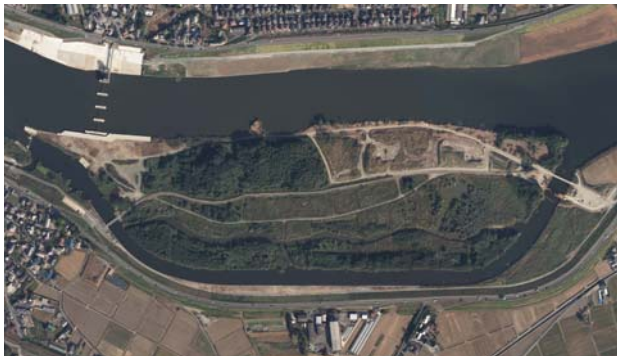
整備後の状況
