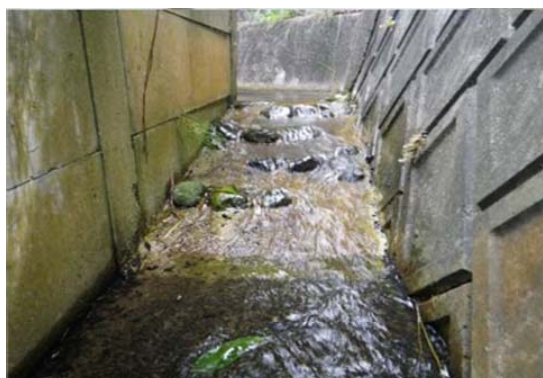
川裏水路段差に斜路設置(御徳地区)
