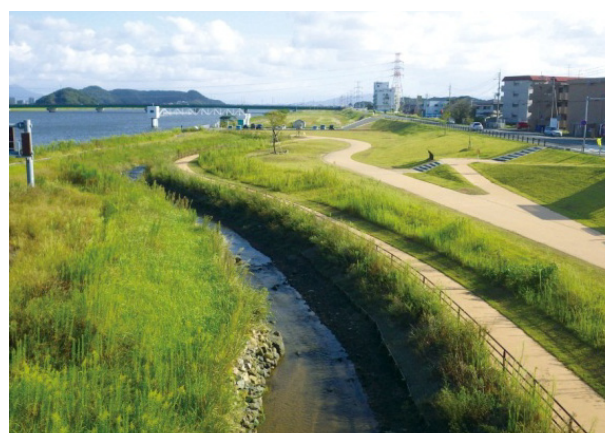
写真 37 遠賀川河口堰の多自然魚道（左：整備前、右：整備後）
