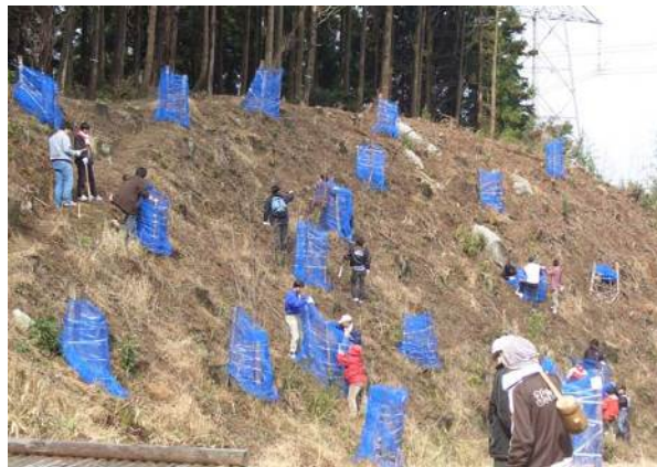
写真 31 植樹の状況（嘉麻市）
