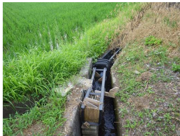
写真 15 御徳地区水田魚道（川裏）
