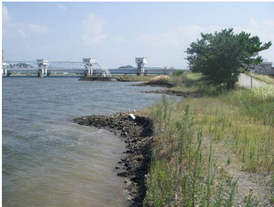
写真 36 水制工による干潟の保全
