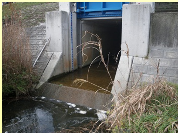
写真 7 樋門・樋管の排水路の落差
