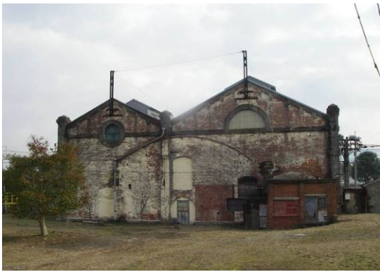
写真 1 遠賀川水源地ポンプ室
