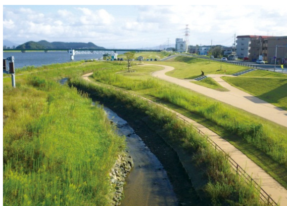
写真 12 遠賀川河口堰の多自然魚道
