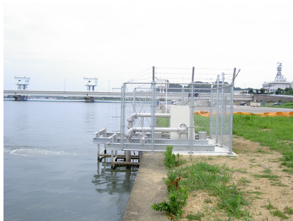
写真 18 河口堰の水質保全施設
