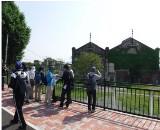
JRウォーキング(遠賀川水源地ポンプ室)
