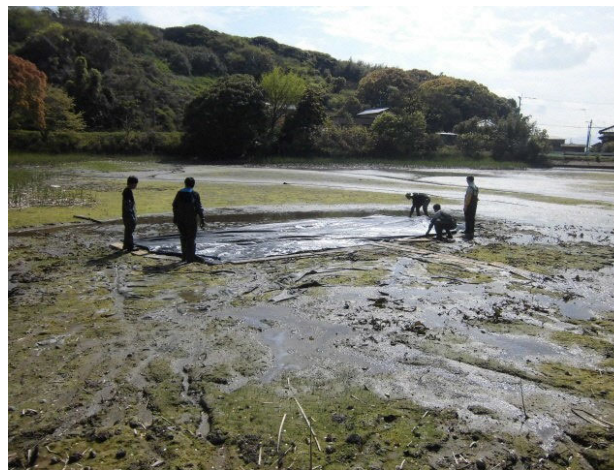
スイレン抑制遮光シート設置作業
