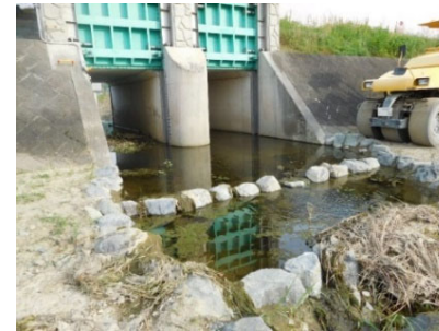
樋管前段差解消(近景)
