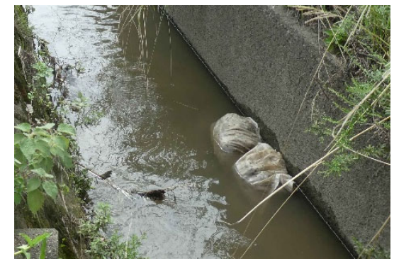
植生土のう設置状況
