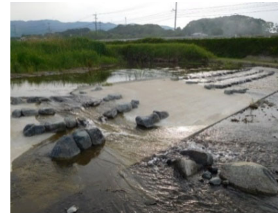
高野床固改良による段差解消
