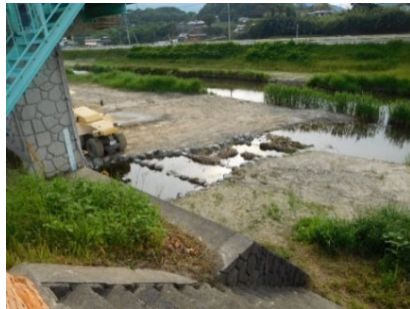
樋管前段差解消(遠景)
