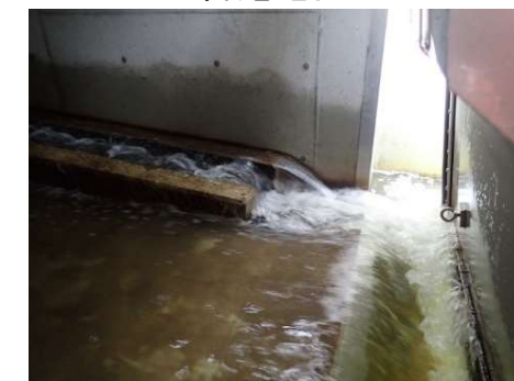
下境地区（排水樋管改良）
