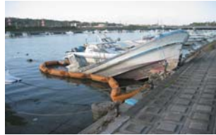
乗り上げによる護岸の損傷
