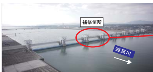
遠賀川河口堰
