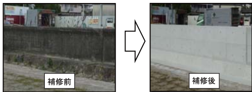
パラペット堤防補修
