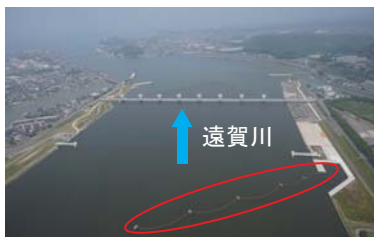
塵芥捕捉施設(網場)
