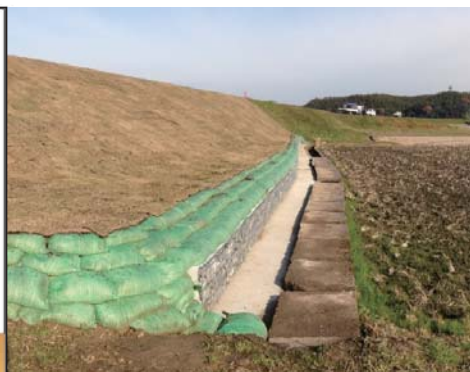
堤防のり尻に設置したドレーン工
