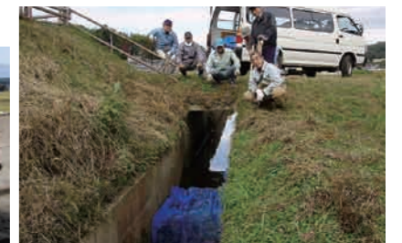
水質浄化用の炭設置
