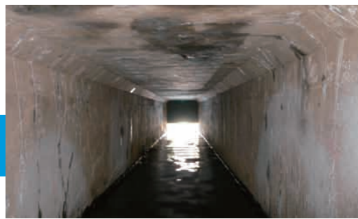
函体補修 施工前
