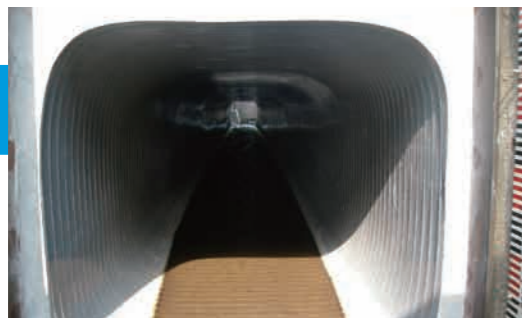
函体補修 施工後
