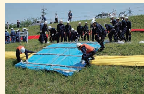
防災訓練 (シート張り工法)
