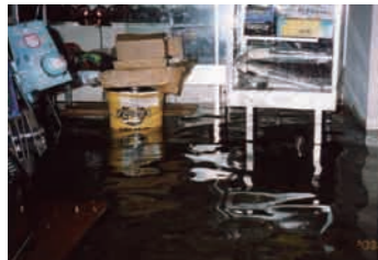
直方地区浸水状況
