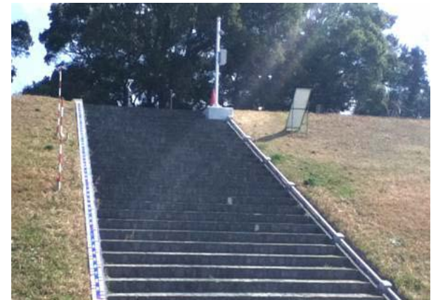
簡易水位計(遠賀川(北九州市))
