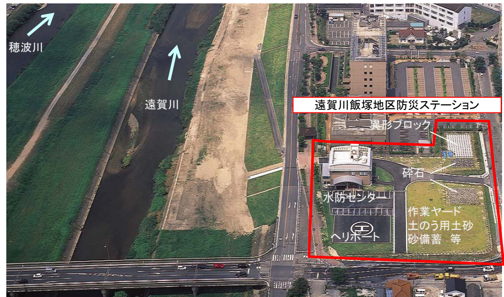
河川防災ステーションの整備事例 遠賀川飯塚地区防災ステーション(遠賀川)
