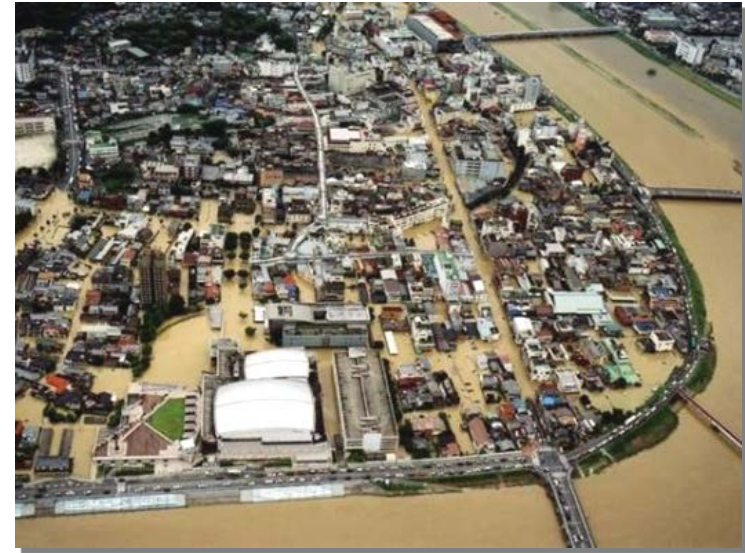
平成15年7月 (飯塚市街地の浸水状況)
