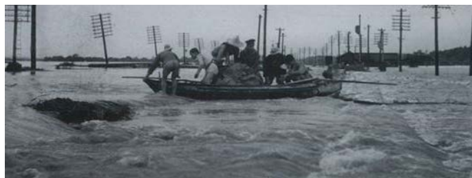
植木破堤に伴う避難状況（鞍手駅周辺）
