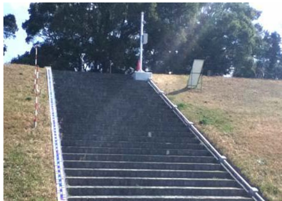
簡易水位計の設置
