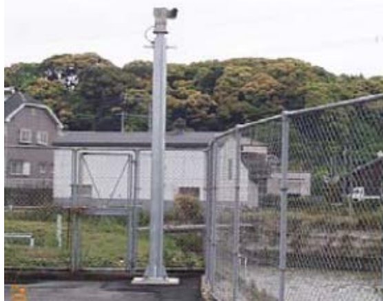
河川監視カメラの設置
