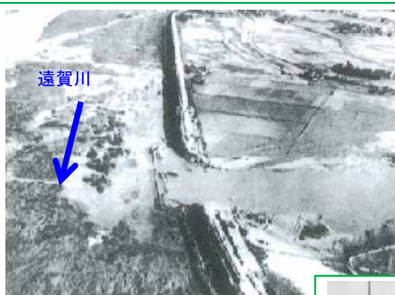
破堤氾濫による浸水状況
