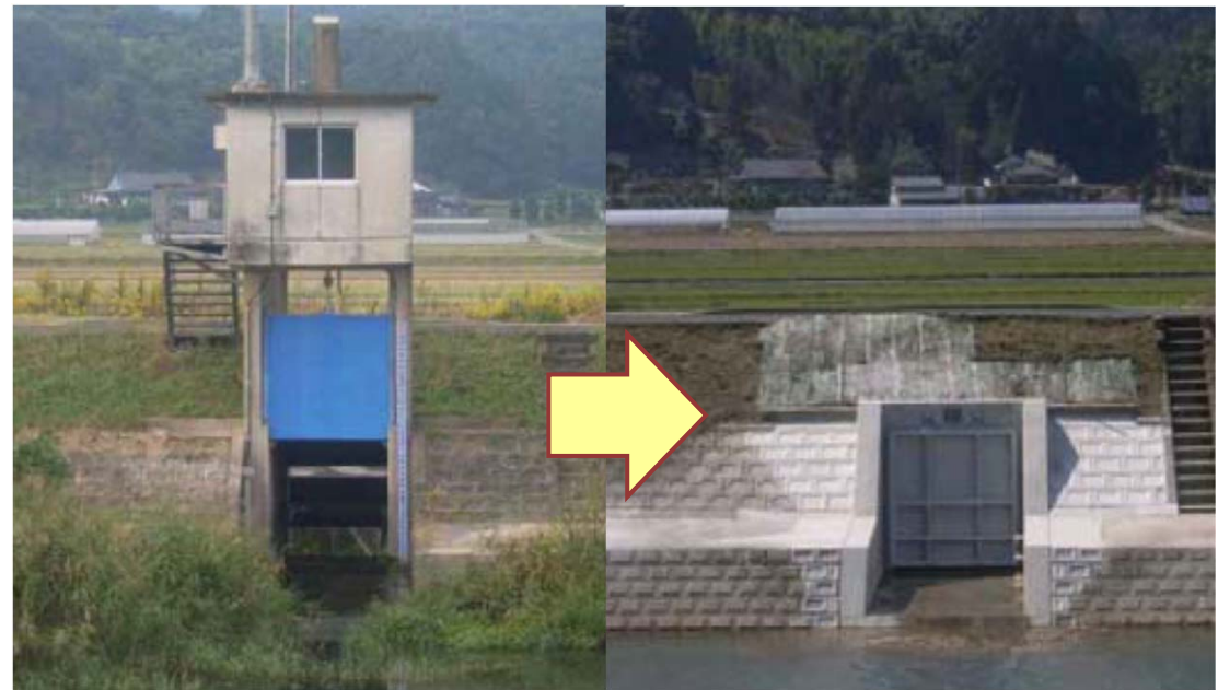
■操作員による操作を必要としないフラップゲートへの改良(無動力化)
