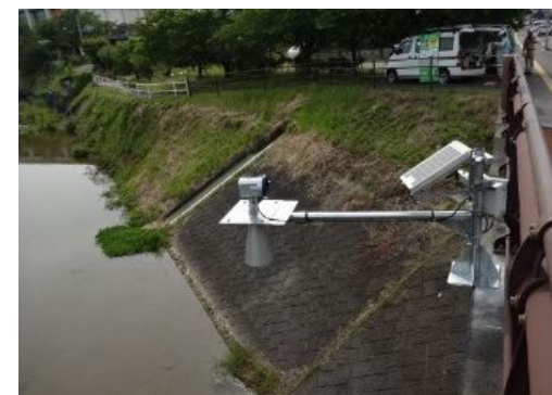
危機管理型水位計の設置事例
