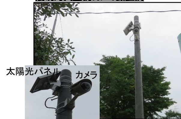
簡易河川監視カメラ設置例
