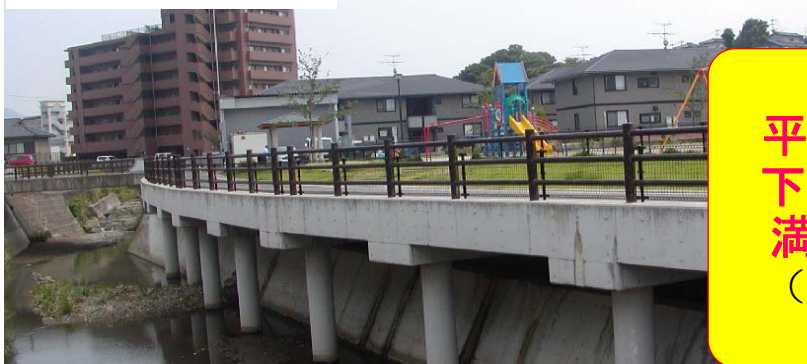
下上津役地下調節池
