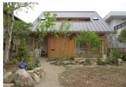
福岡市内にある雨水ハウス
