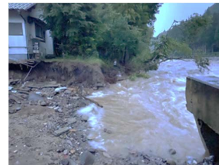
添田町被災状況(R2.7.6)
