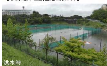
【事例：霧が丘調整池(横浜市)】
