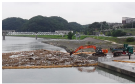
岸に引き寄せたゴミを水から引き上げるパワーショベル
