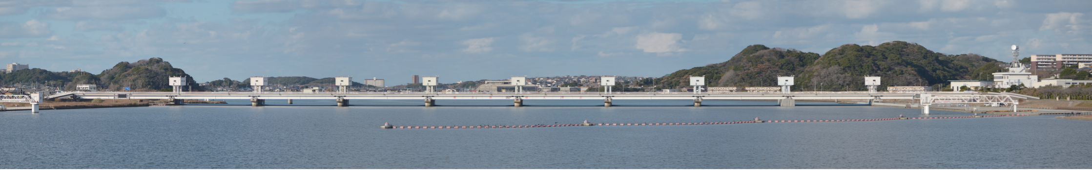
遠賀川河口堰は河口から2kmの地点に、約5年の歳月をかけて昭和55年に完成した可動堰です。堰の長さ517m(自動車 約130台分)、貯水量1,114万m³(福岡ドーム 約6杯分)です。
