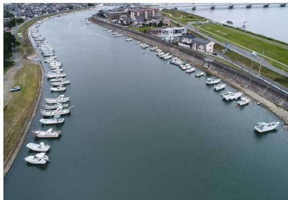
写真 2.3.43 遠賀川河口域における不法係留船の状況 (支川西川：平成 30 年 10 月)
