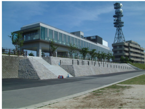
写真 2.3.31 遠賀川地域防災施設「遠賀川水辺館」（直方市）
