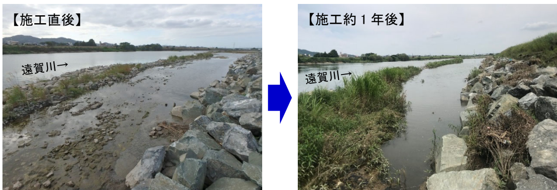
写真 5.1.4 河道掘削に伴う湿地環境の創出
