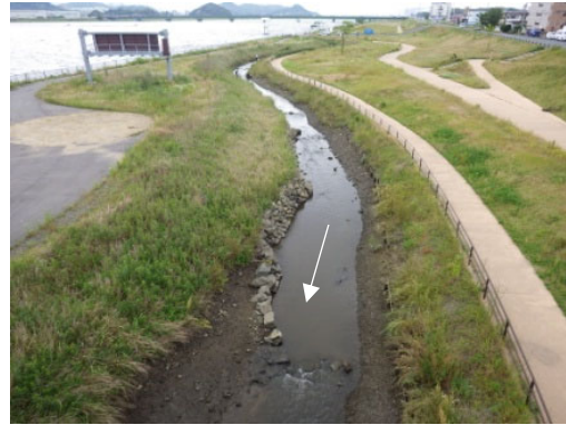
写真 2.3.19 多自然魚道 (上流側)
