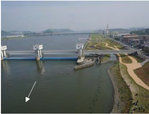
写真 2.3.18 遠賀川河口堰の 多自然魚道
