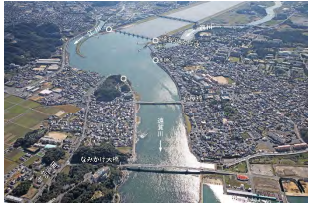
写真 2.3.13 遠賀川河口部 (芦屋町、河口部より上流を望む)
