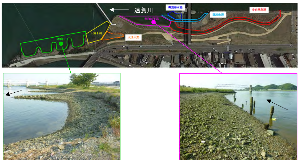
写真 5.1.5 遠賀川河口堰多自然魚道整備とあわせた干潟環境の創出
