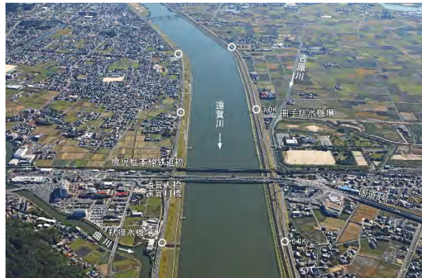
写真 2.3.11 遠賀川下流部 (水巻町、遠賀町上空より望む)
