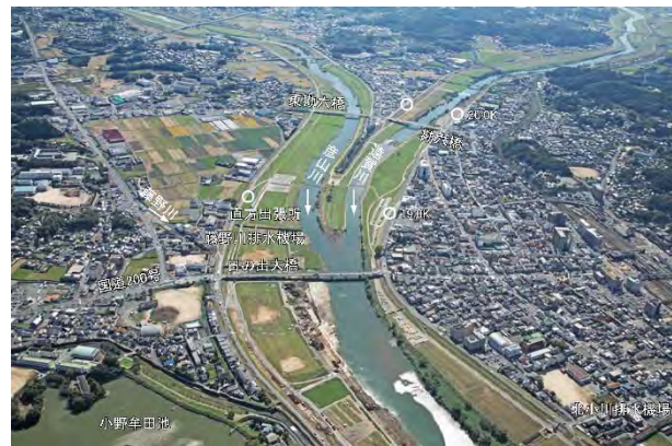
写真 2.3.3 遠賀川中流部（直方市）
