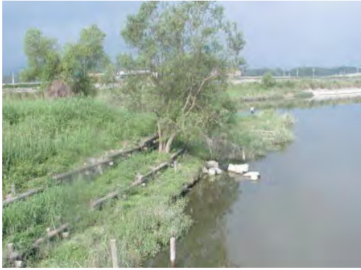
■ 自然に配慮した川づくり事例
