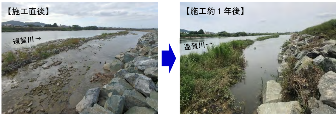
写真 5.1.4 河道掘削に伴う湿地環境の創出
