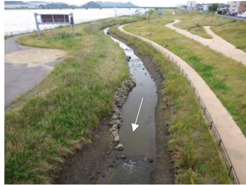
写真 2.3.19 多自然魚道 (上流側)
