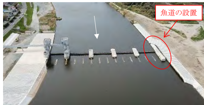
写真 5.1.6 堰改築とあわせた魚道整備（中間堰）
