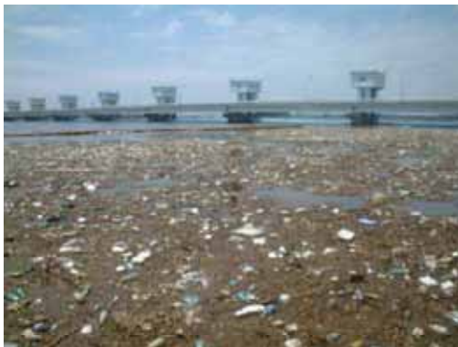
写真2.2.36 出水後の遠賀川河口堰貯水池
