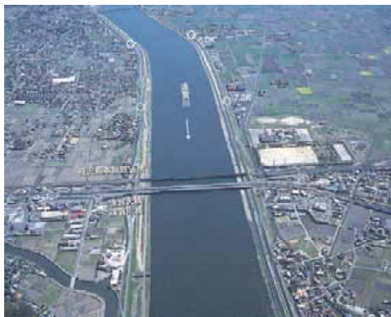
写真2.2.11 遠賀川下流部 (水巻町、遠賀町上空より望む)
