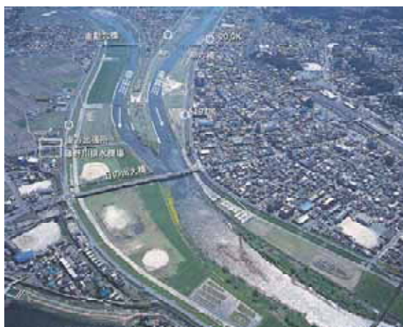
写真2.2.3 遠賀川中流部(直方市)
