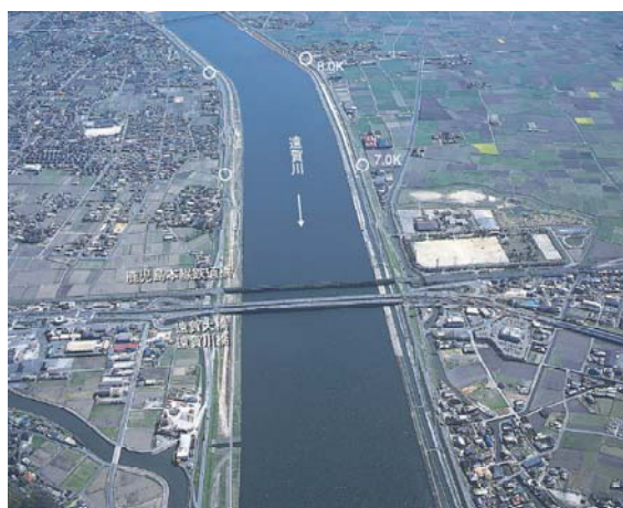
写真2.2.11 遠賀川下流部
