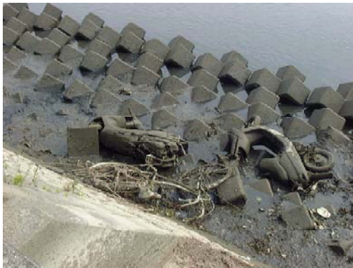
写真2.2.35 ゴミ投棄状況
