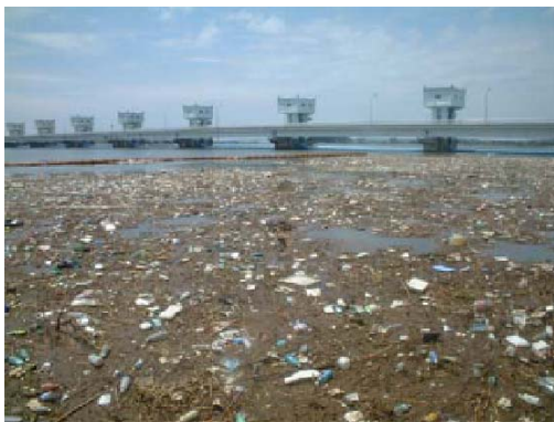
写真2.2.36 出水後の遠賀川河口堰貯水池
