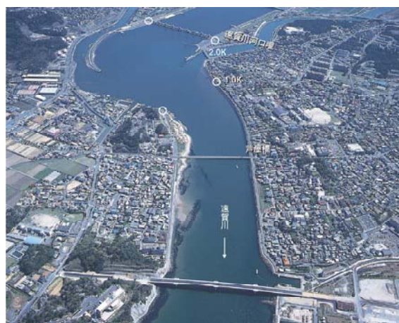
写真2.2.13 遠賀川河口部 (芦屋町、河口部より上流を望む)
