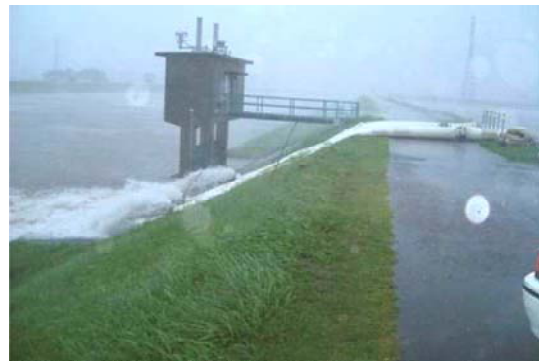
写真4.3.5 排水ポンプ車の稼働状況 (平成15年7月19日出水時)
