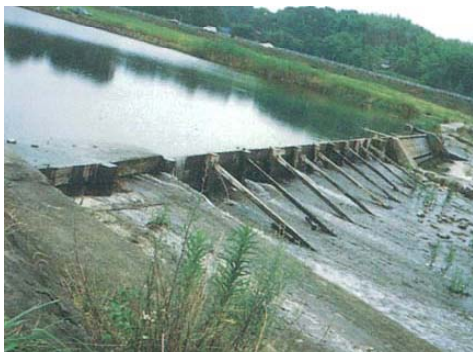
改修前の岡森堰
