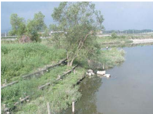
■自然に配慮した川づくり事例
