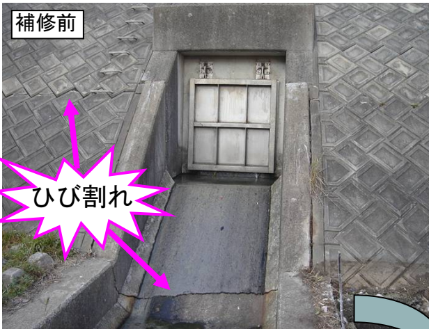
河川管理施設更新による対応状況 【護岸・樋管開水路補修】
