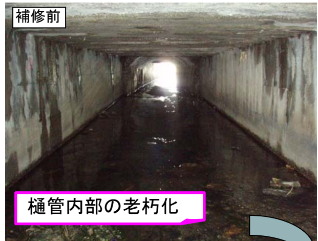
河川工作物関連応急対策事業 による対応状況【樋管函体補修】
