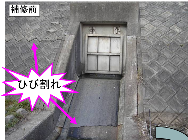
河川管理施設更新による対応状況 【護岸・樋管開水路補修】
