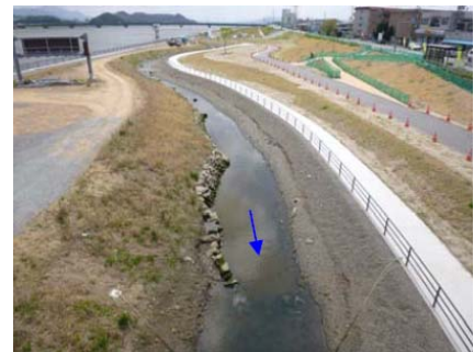
多自然魚道(新設:施工後)
