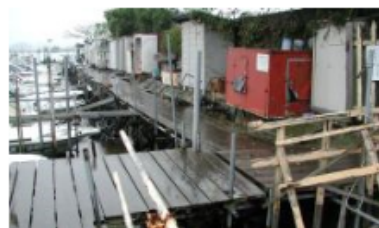
河川内に栈橋や倉庫を設置
