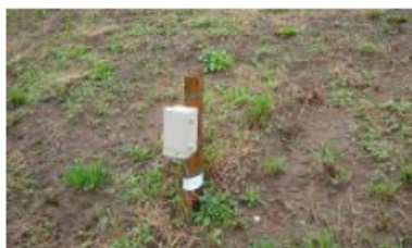
河川内に電源ボックスを設置
