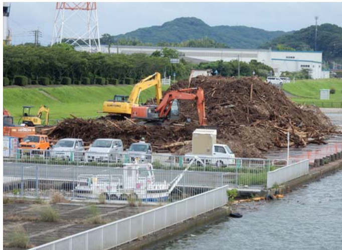
ゴミの陸揚げ状況(7月18日撮影)
