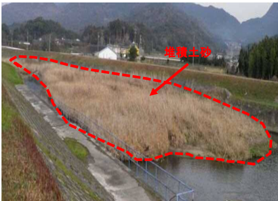
堆積土砂の撤去前
