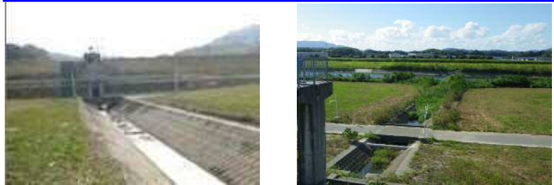
排水路の改良工事(整備前)
