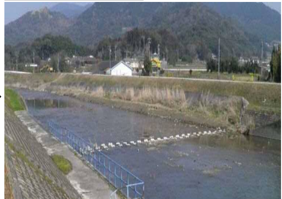
堆積土砂の撤去後
