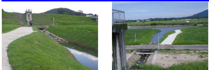
排水路の改良工事(整備後)
