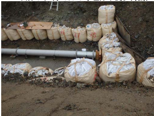
埋設送水管敷設状況 平成29年4月26日15時 左岸下流より撮影
