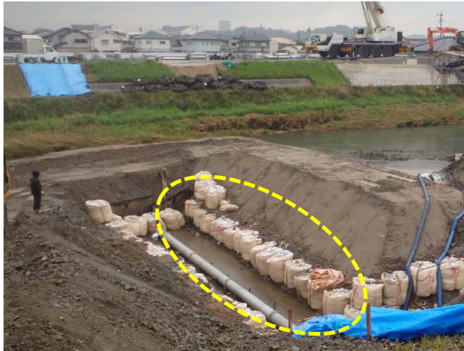
埋設送水管敷設状況
