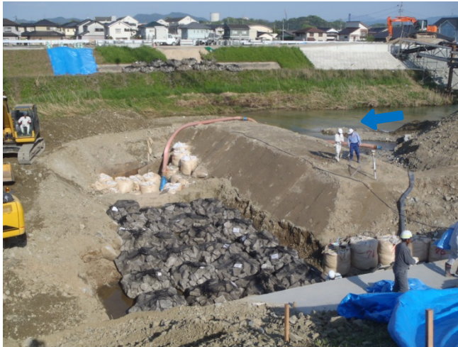
埋設送水管敷設状況(袋詰根固め据付) 平成29年4月28日16時 左岸下流より撮影
