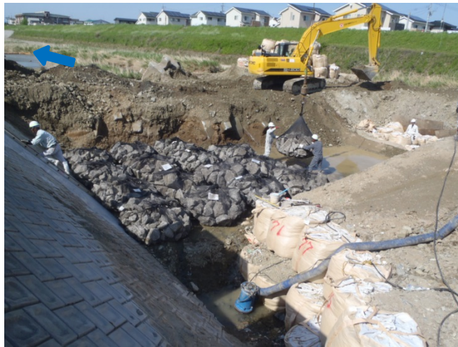
埋設送水管敷設状況(袋詰根固め据付) 平成29年4月28日16時 左岸下流より撮影
