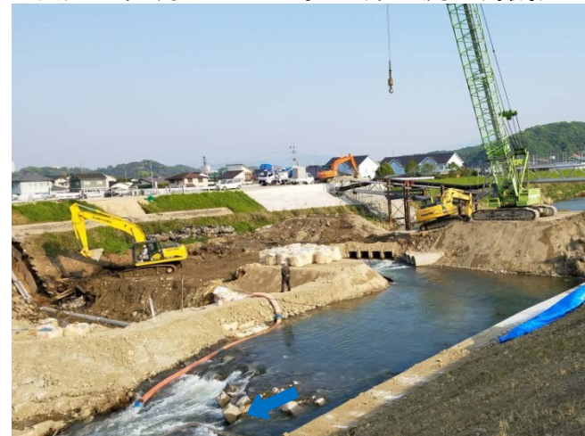
現場全景 平成29年4月30日 17時 左岸下流より撮影
