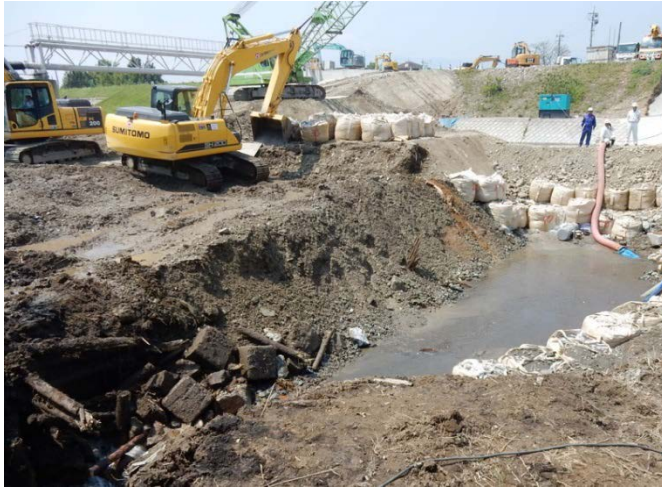
埋設送水管の敷設状況(左右岸の埋設送水管が繋がる) 平成29年4月30日16時 右岸下流より撮影
