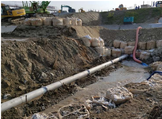
埋設送水管の敷設状況(左右岸の埋設送水管が繋がる) 平成29年4月30日16時 右岸下流より撮影
