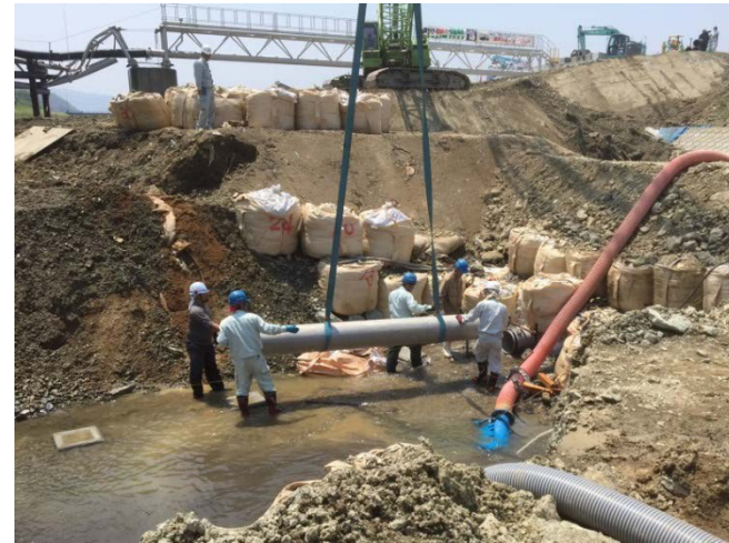
埋設送水管の敷設状況 平成29年4月30日12時 右岸下流より撮影
