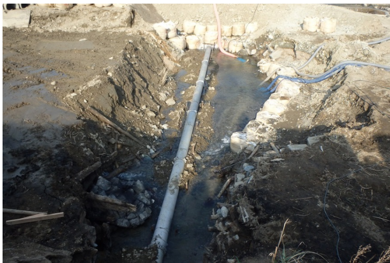
埋設送水管敷設状況(袋詰根固め据付) 平成29年5月1日17時 右岸下流より撮影
