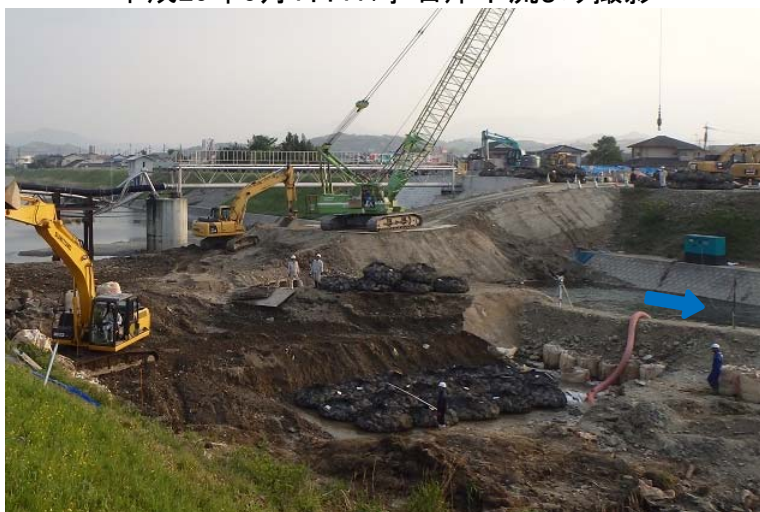
埋設送水管敷設状況(袋詰根固め据付) 平成29年5月1日17時 右岸下流より撮影
