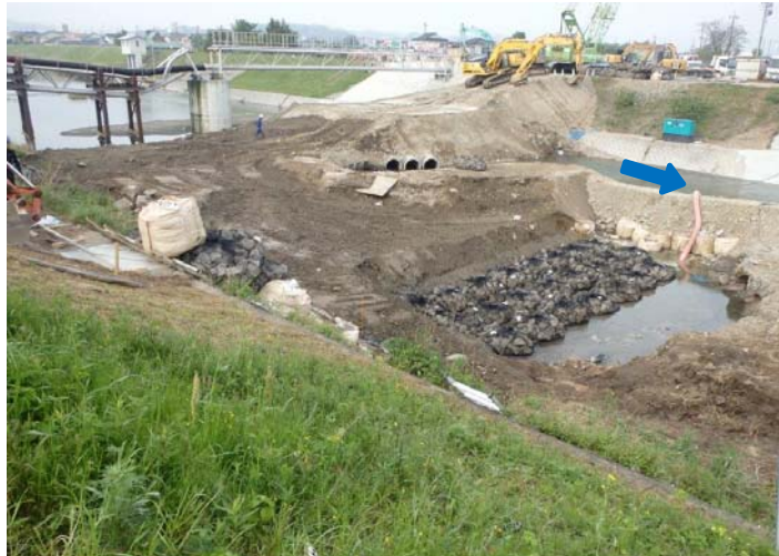
仮送水管敷設状況（根固め据付・仮締切撤去） 平成29年5月2日17時 右岸下流より撮影
