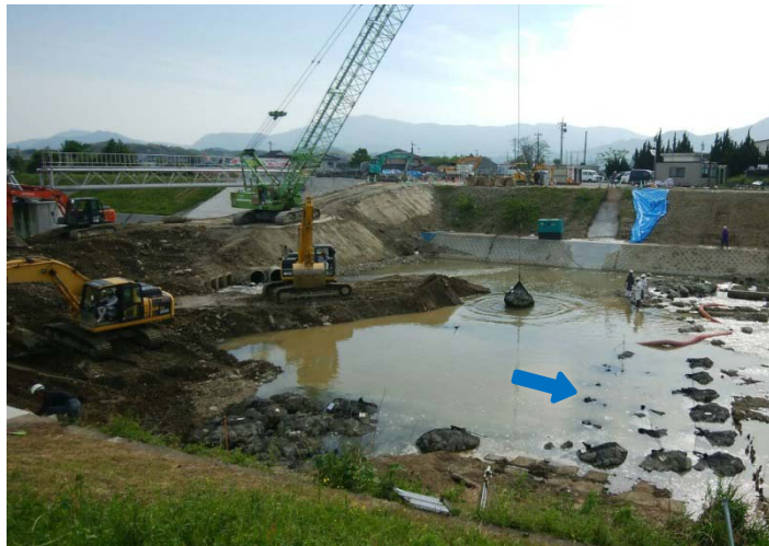
仮送水管敷設状況（根固め据付・仮締切撤去） 平成29年5月2日17時 右岸下流より撮影
