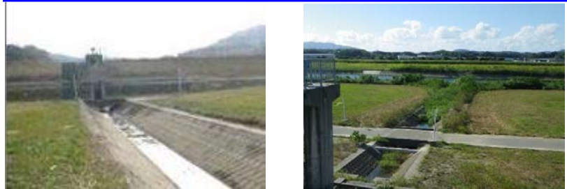
排水路の改良工事(整備前)
