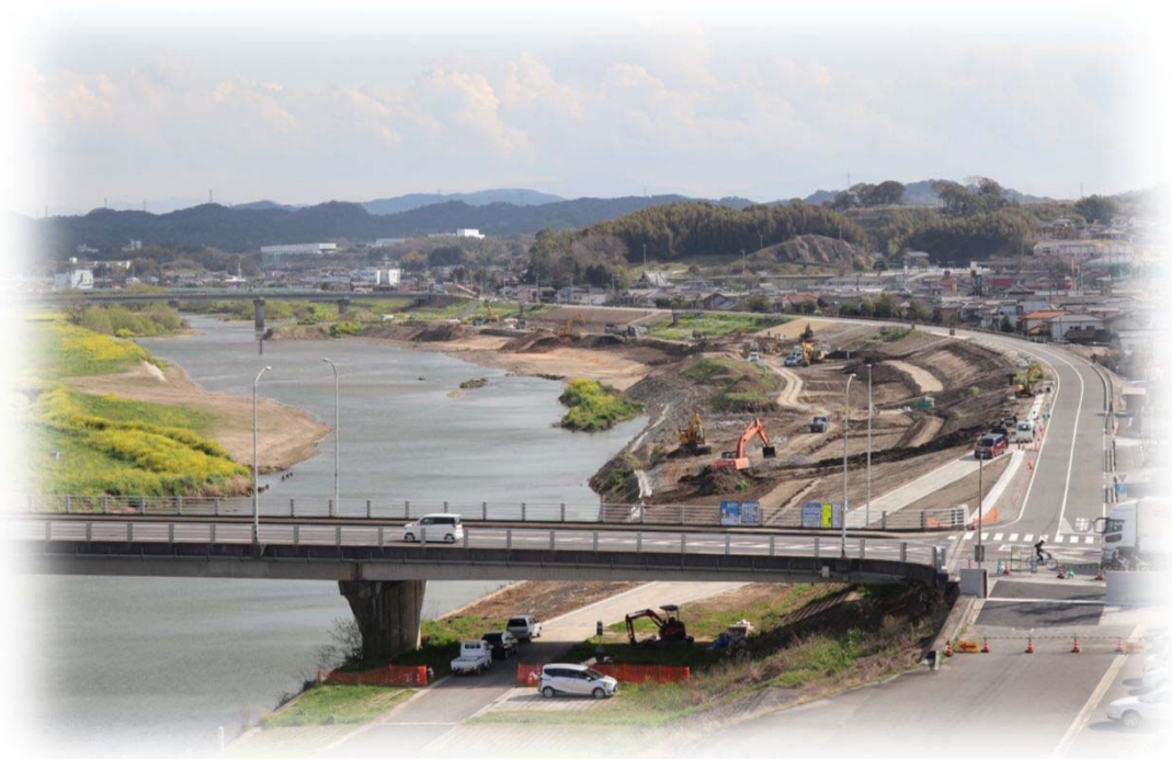
河川工事の状況【事務所屋上より彦山川上流を望む】
