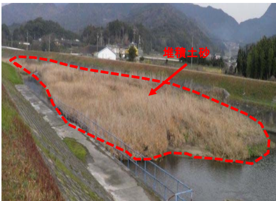
河道の緊急維持掘削を実施
