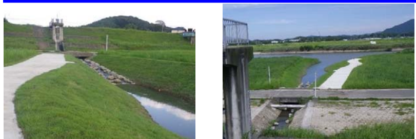
排水路の改良工事(整備後)
