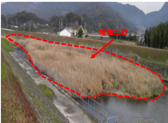
河道の緊急維持掘削を実施
