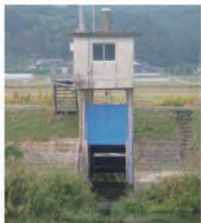
操作員による操作を必要としないフラップゲートへの改良 (無動力化)
