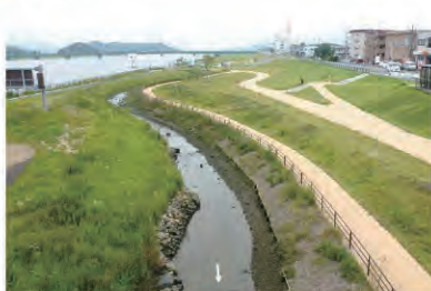
遠賀川河口堰の多自然魚道
