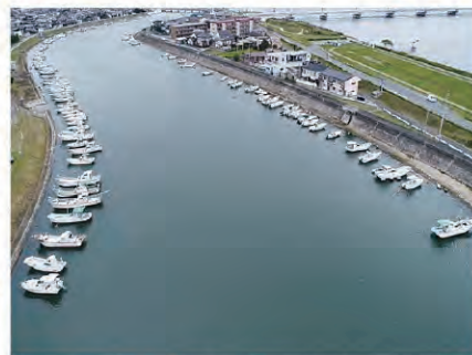
不法係留船の状況 (西川:平成30年10月)
