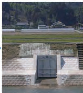
操作員による操作を必要としないフラップゲートへの改良 (無動力化)
