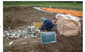
(4) 手作業で分別し処分
