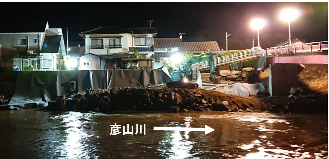
復旧状況(7月11日夜間撮影)
