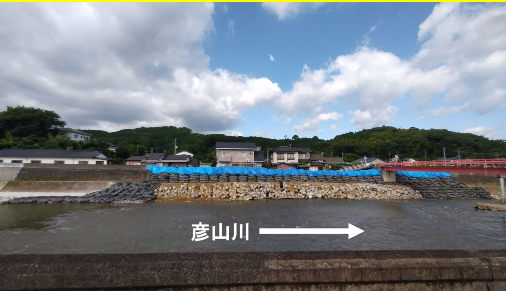
復旧完了(7月16日 9時00分撮影)
