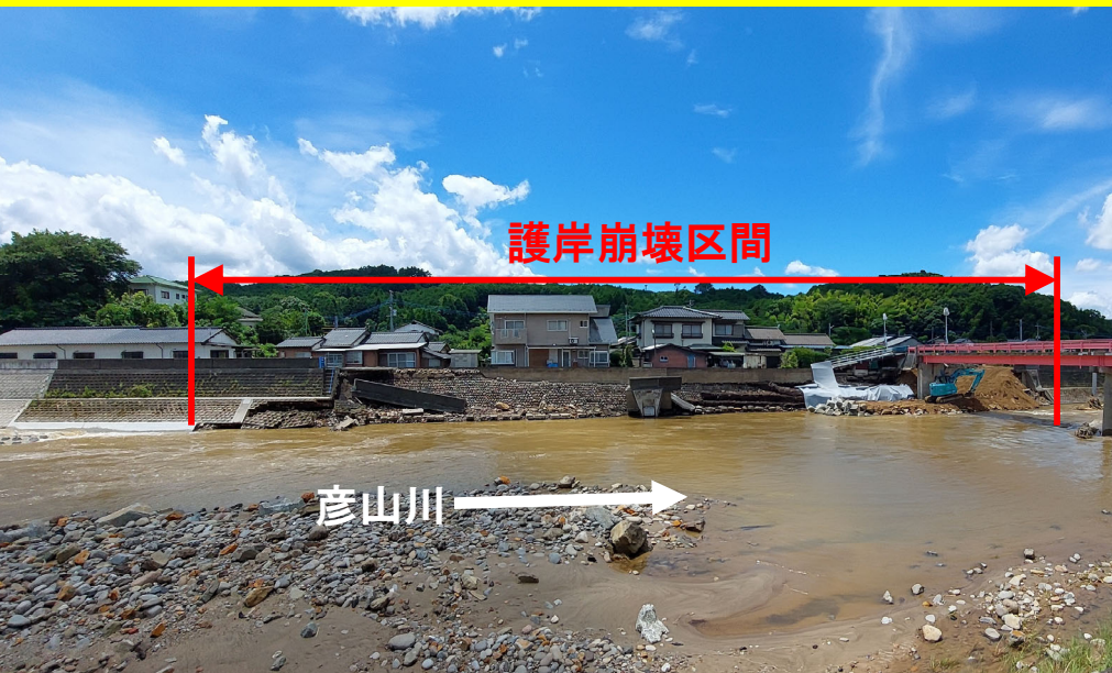
被災状況(7月11日撮影)
