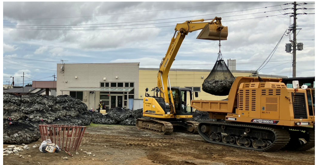
資材運搬状況(7月13日撮影)
