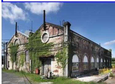
世界遺産「遠賀川水源地ポンプ室」
