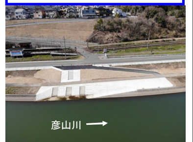
新糯橋下流左岸を望む(R5.3撮影)
