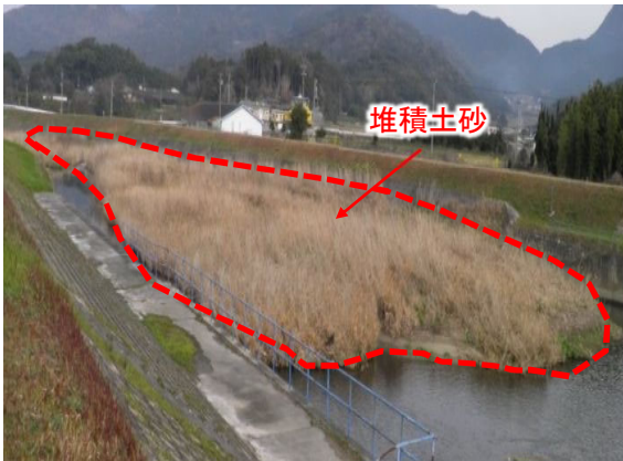
河道の緊急維持掘削を実施
