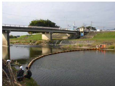
オイルフェンス展張完了
