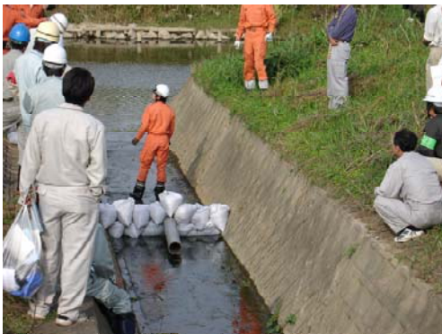
水路内での土嚢積み
