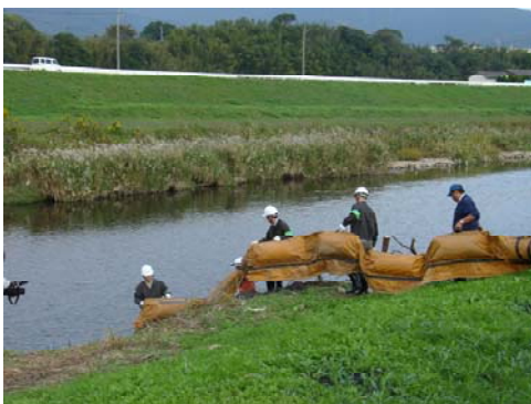
オイルフェンス展張作業
