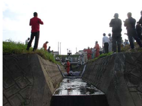
水路内での吸着フェンス設置
