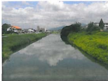
中元寺川・後藤寺地区（松ノ木橋から下流）
