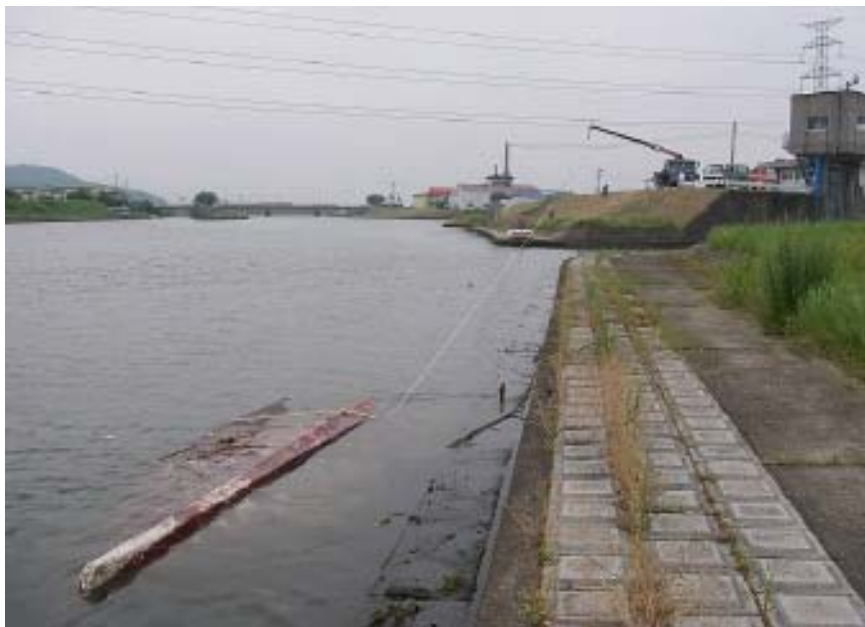
①沈船にロープを取り付け引き揚げ箇所まで移動
