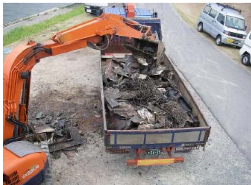
④トラックに積めないため破碎して撤去
