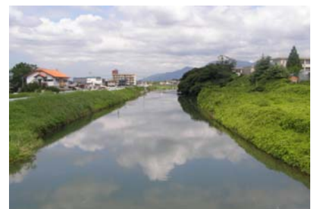
中元寺川後藤寺地区(松ノ木橋から下流の状況)
