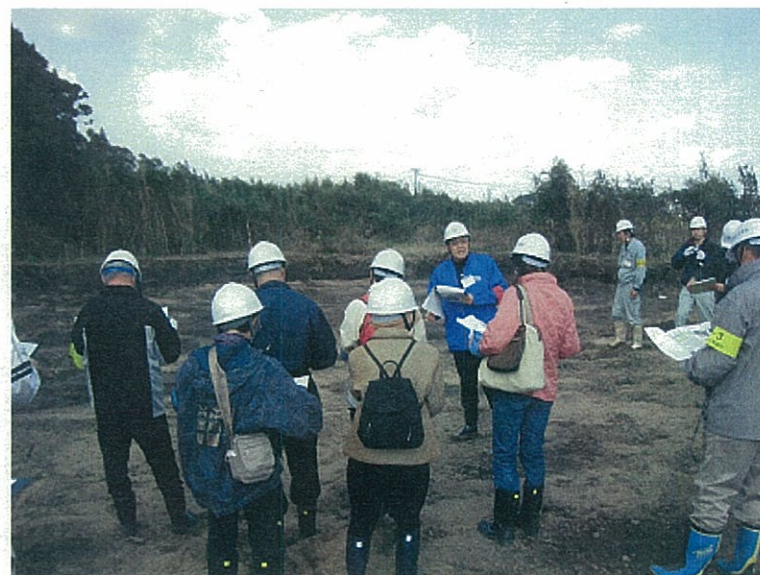
掘削工事の確認
